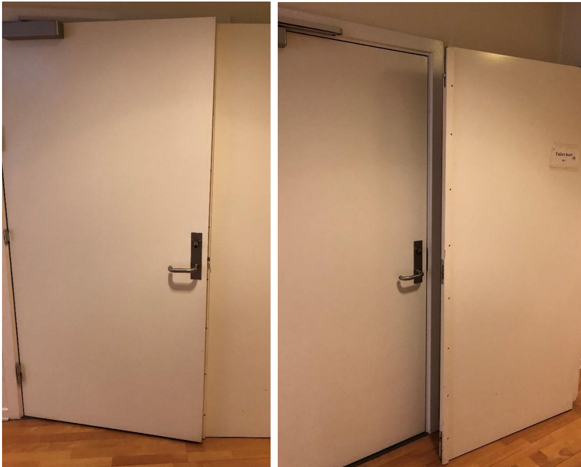
Figur 1 Billede til højre viser hvorledes dør til teknikrum ikke kan lukke i, og holder røgopdelingsdøren.
